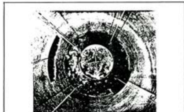
Figura 8. Reparación con Concreto Proyectable en Horno Rotatorio de Cal 10
