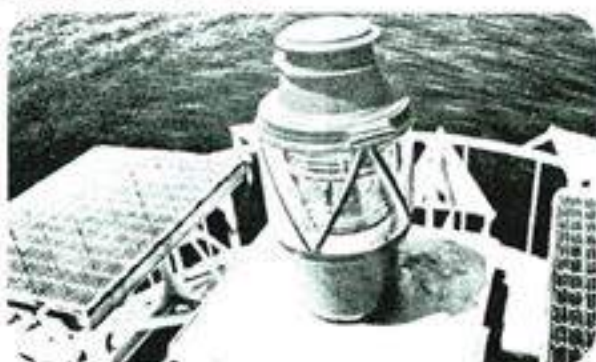
Celda Solar para la alimentación de un faro en Indonesia.
