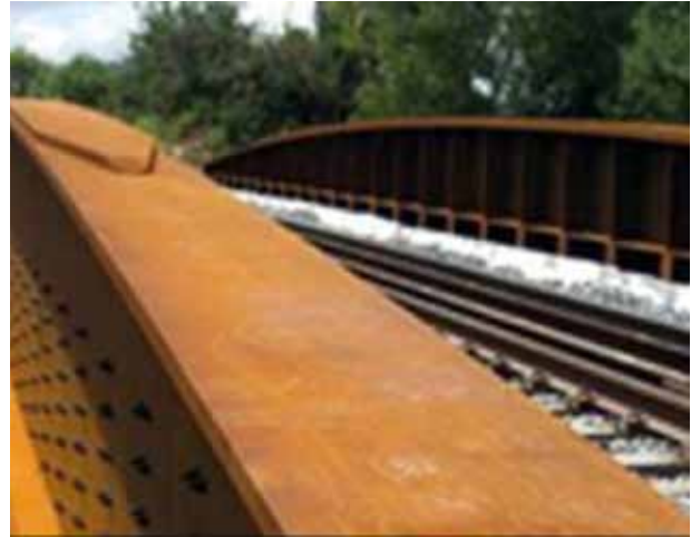
Figura 3.- Puente de ferrocarril en acero autopatinable.
