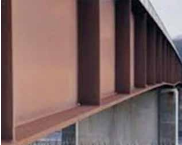
Figura 2.- Puente carretero en acero autopatinable.
