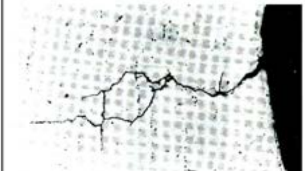
Típica fisura ramificada producida por corrosión bajo tensiones. Fig. 7.
