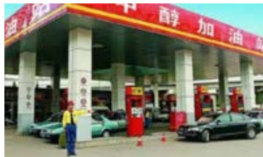
Figura 10. Estación de combustible de Metanol en China [5].
