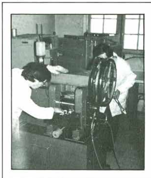
Figura 16.— Laminación de una miniplaca.
