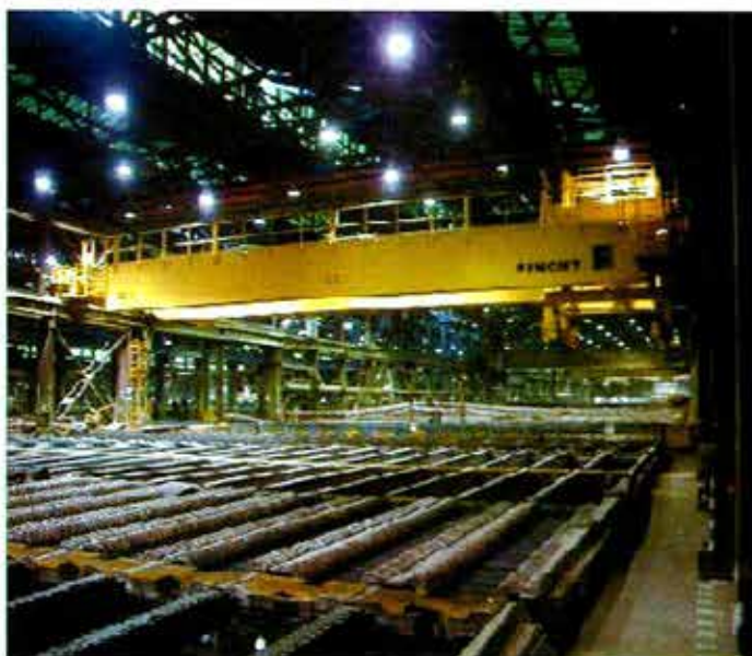
Figura 11: Puente Grúa Femont ("Bay Carrier") portando el riel para el "carro porta lingada" en el extremo derecho
