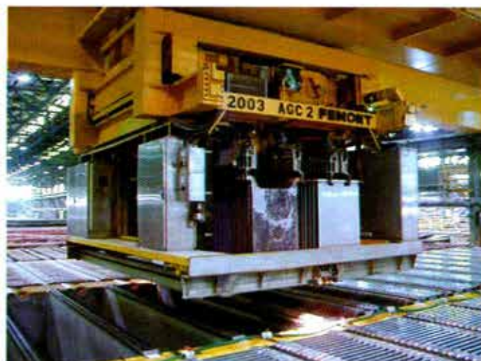
Figura 12: Puente Grúa Femont portando en el riel el "carro porta lingada" con una lingada de ánodos y una lingada de cátodos permanentes.
