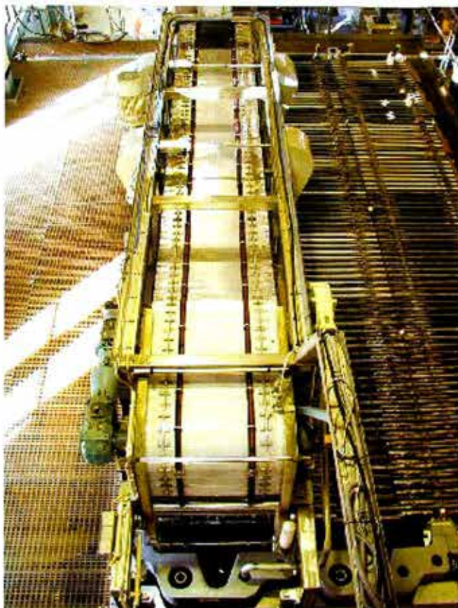
Figura 15. Sistema de Desborre de Celdas.
