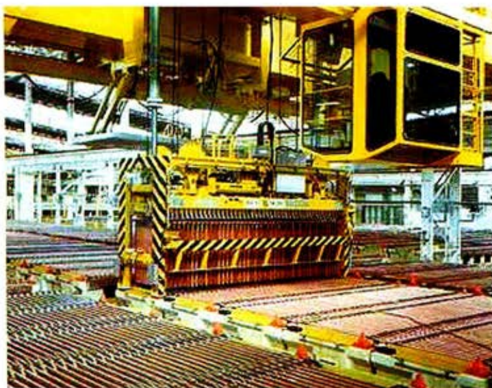
Figura 14: Punte Grúa Kunz totalmente automatizada.
