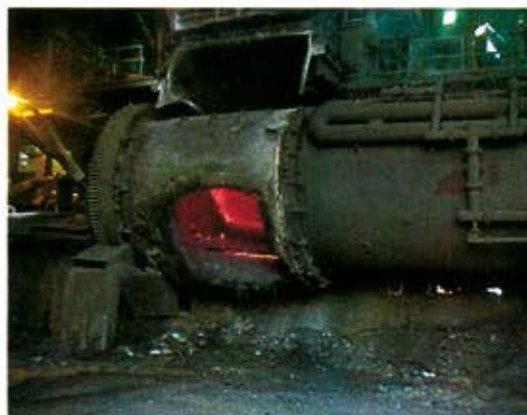
Fig. N°2: Reparación general realizada al CT.
