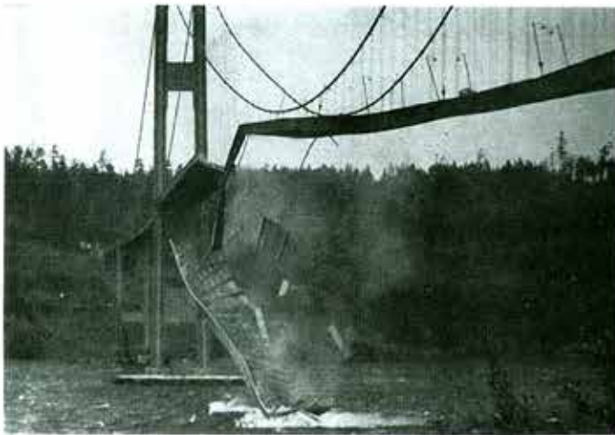
Figura 9. Pocos minutos después de que cayera la primera pieza de concreto, esta sección de 200 metros se rompió cayendo al río. Al lado derecho de la fotografía, sobre el puente, puede verse un automóvil.
